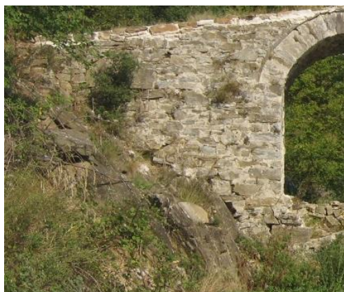
Εικόνα 19: Έδραση ακροβάθρου στο βραχώδες πρανές και μεσοβάθρου.
