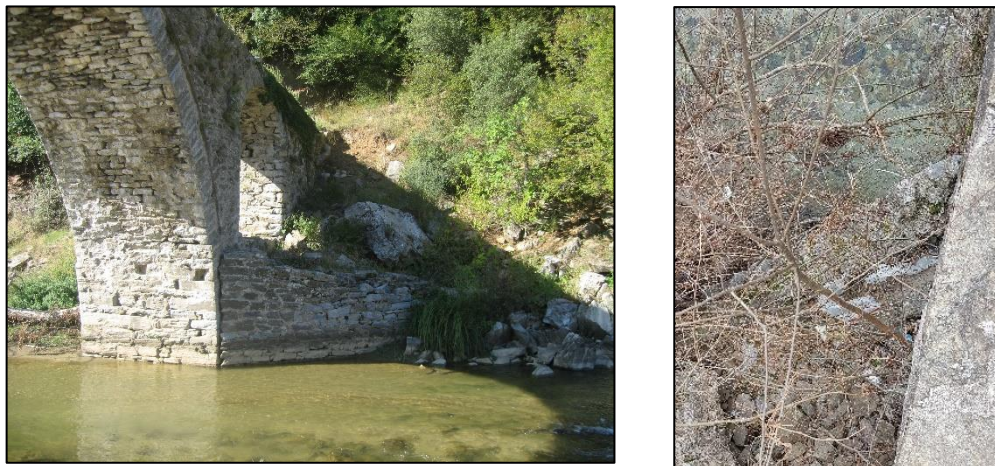
Εικόνα 12: Πτερυγότοιχος προστασίας ακρόβαθρου ανάντη (αριστερά κάτοψη).
