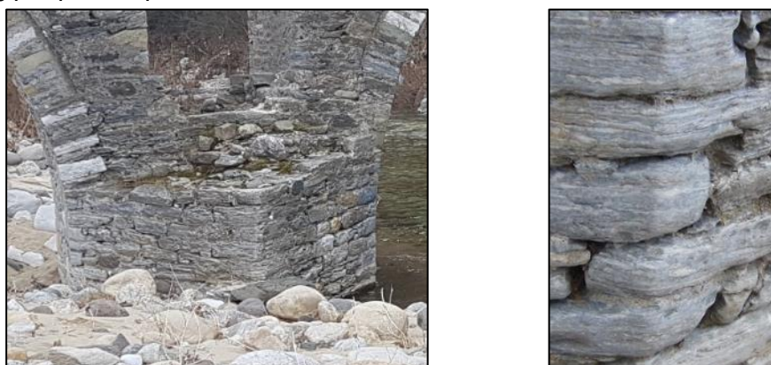
Εικόνα 13: Θωράκιο προστασίας βάθρου ανάντη (αριστερά εμπλοκή λιθοσωμάτων).
