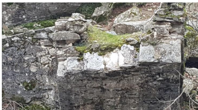
Εικόνα 17: Λιθωσώματα τόξων (γέφυρα στο 8 ο χλμ.).
