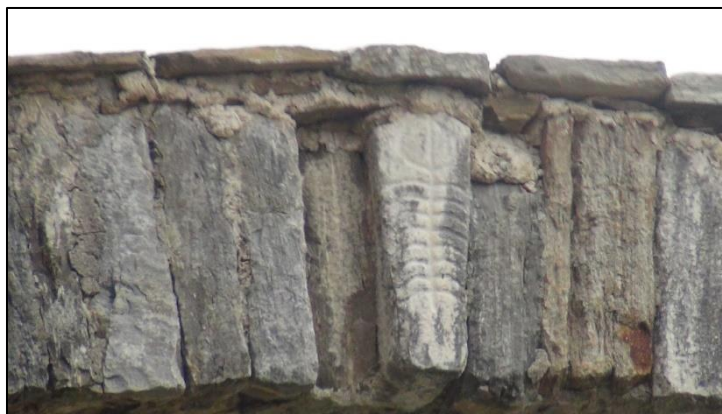
Εικόνα 30: Απώλεια λιθοσώματος κλειδιού κατάντη όψης δυτικού τόξου.
