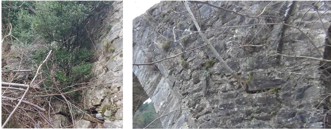
Εικόνα 24: Βλάστηση σε γειτνίαση και στις όψεις του γεφυριού.
