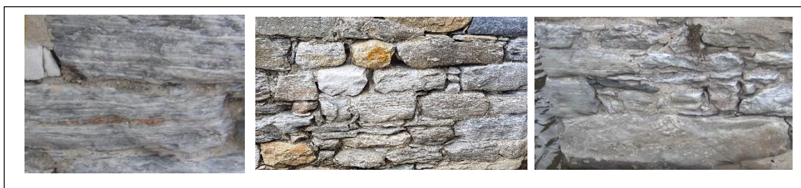
Εικόνα 11: Λιθοσώματα βάθρων γεφυριού.
