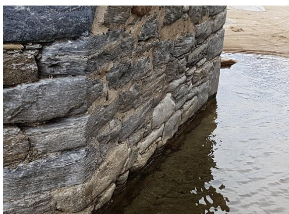
Εικόνα 19: Έδραση ακροβάθρου στο βραχώδες πρανές και μεσοβάθρου.
