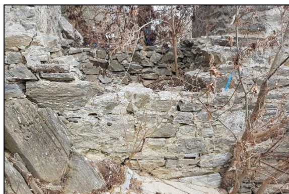
Εικόνα 26: Τοπικές καταρρεύσεις στις ποδιές δυτικού και ανατολικού ανακουφιστικού ανοίγματος.
