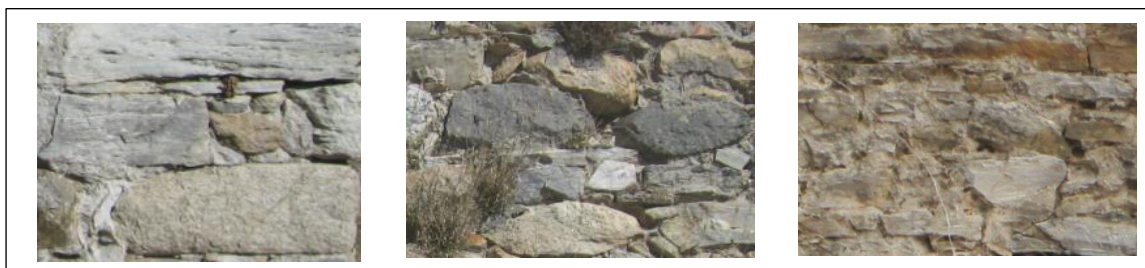
Εικόνα 10: Λιθοσώματα τυμπάνων γεφυριού.
