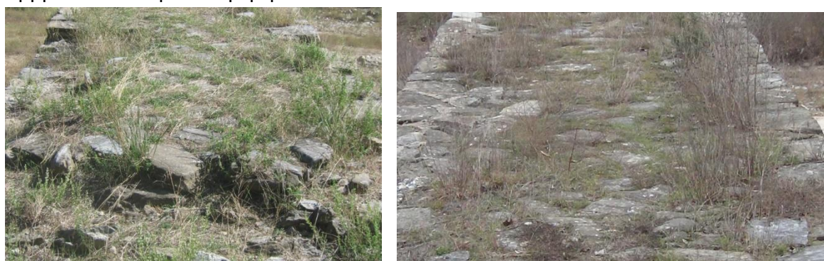
Εικόνα 14: Λιθόστρωτο καταστρώματος πριν και μετά τις επεμβάσεις.
