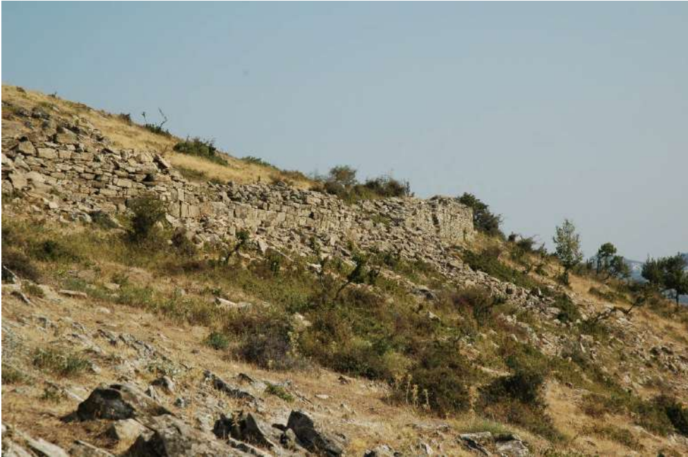
Εικόνα 69 Κιμμέρια. Μερική άποψη του φρουρίου. Πρώιμη Εποχή του Σιδήρου και Βυζαντινή Περίοδος
