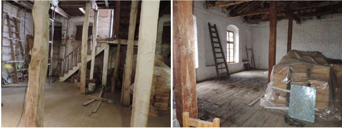
Εικόνες 57-58 Νότιο κτίριο. Αριστερά: Άποψη υπογείου. Διακρίνεται η σκάλα προς το ισόγειο. Δεξιά: Άποψη ορόφου
