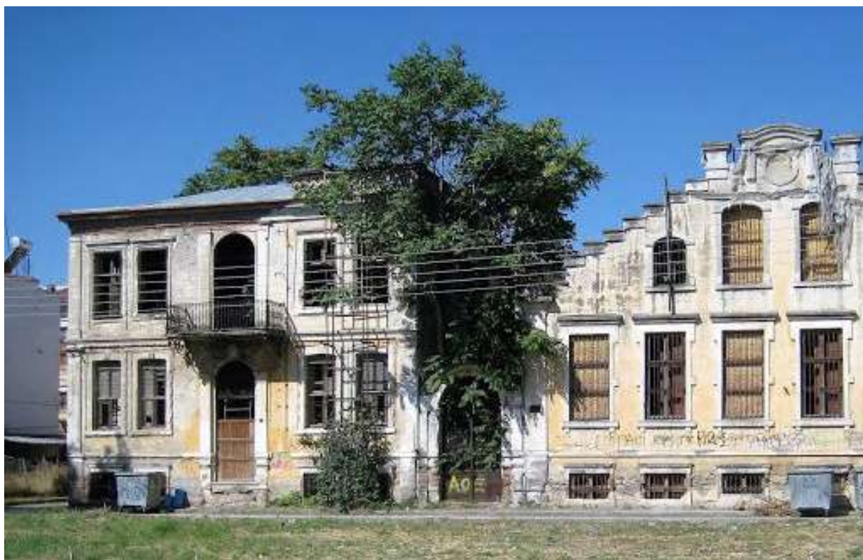
Εικόνα 6 Άποψη (ανατολικά) του κτιρίου καπναποθήκης και κτιρίου γραφείων, επί των οδών 12 Αποστόλων, Αβδήρων & Ανδρούτσου
