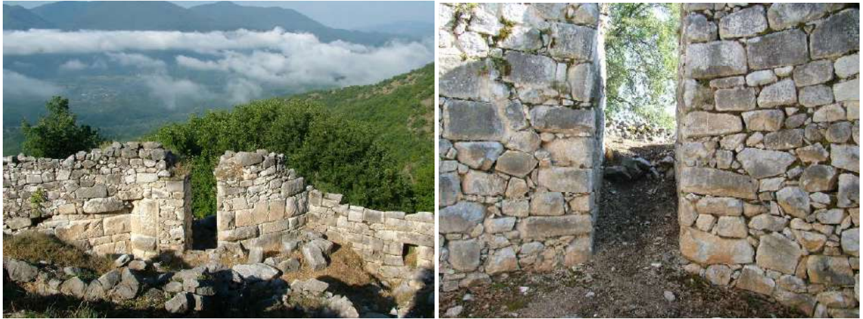
Εικόνα 99 Απόψεις πύργων στο φρούριο της Καλύβας
