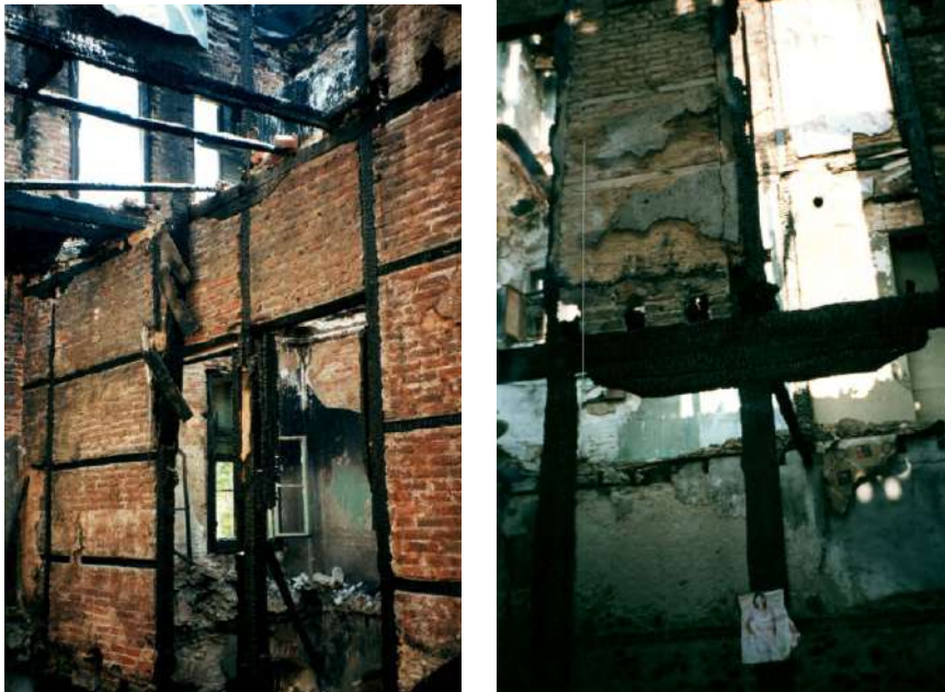
Εικόνες 11-12 Άποψη (εσωτερικά) του κτιρίου γραφείων, μετά την πυρκαγιά που εκδηλώθηκε στο συγκρότημα το 2001 (πηγή: Αρχείο ΥΝΜΤΕΑΜΘ)
