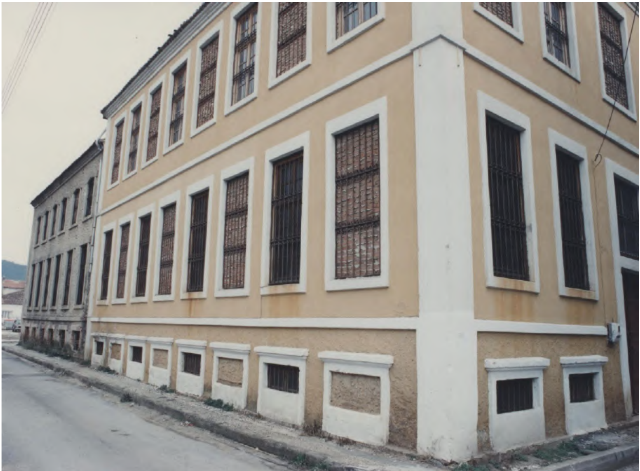
Εικόνα 52 Άποψη του κτηρίου Β (νότιου) από τα νοτιοδυτικά. Διακρίνεται το κτίριο Α (στα αριστερά)
