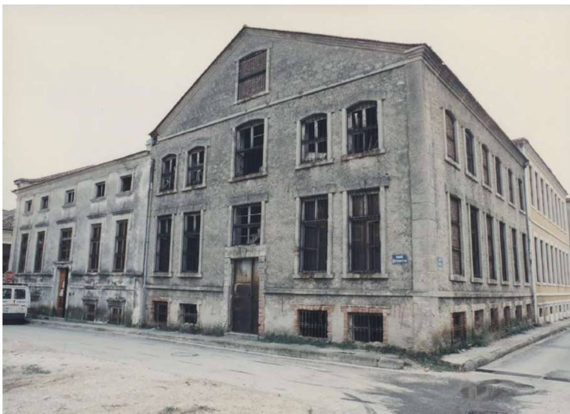
Εικόνα 51 Αποψη του κτιρίου Α (βόρειου) από τα βόρεια. Διακρίνονται τα κτίρια Β (στα δεξιά) και Δ (στα αριστερά)
