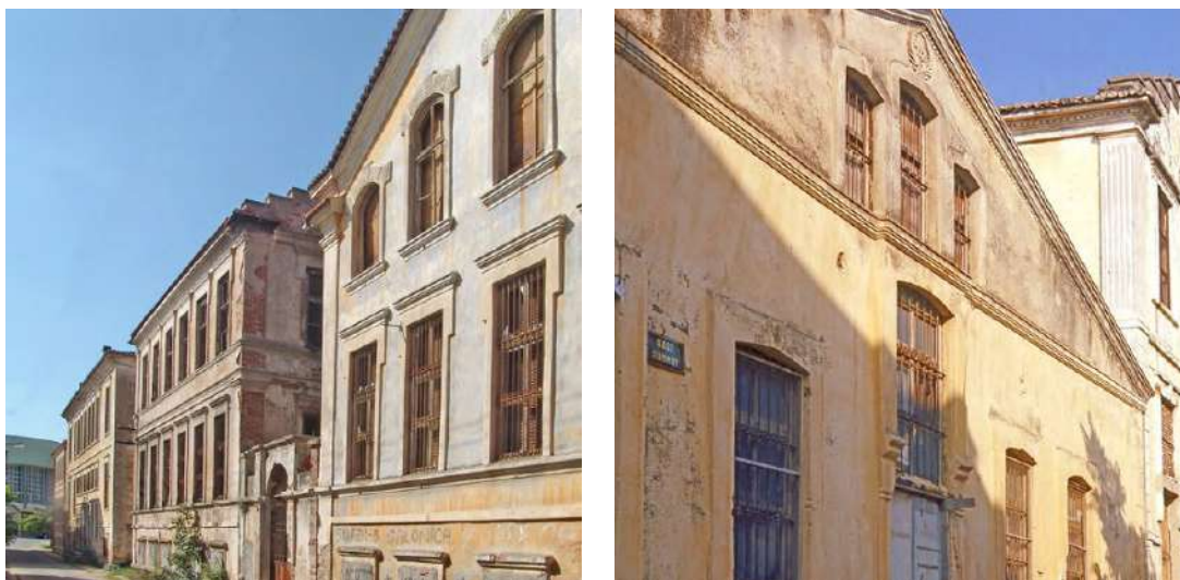
Εικόνες 4-5 Ενδεικτική άποψη της περιοχής Καπναποθηκών Ξάνθης
